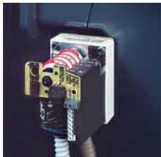
Für den Stellantrieb des Brenners ist bei Bedarf ein dreipoliges Rückführpotentiometer (1000 Ω) für die Positionserfassung des Stellantriebs erforderlich.
