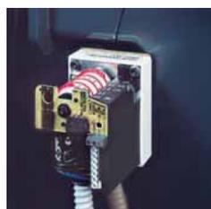
Abhängig vom Stellantrieb des Brenners ist ein dreipoliges Rückführpotentiometer (1000 Ω) für die Positionserfassung des Stellantriebs erforderlich.
