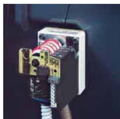
Bei Einsatz des Analog-Signalkonverter wird für dessen Betrieb ein Rückführpotentiometer benötigt. Soll zusätzlich eine Meldung über die Position des Stellmotors aus dem Brenner geführt werden, muss statt des einfachen Rückfuhrpotentiometers ein Doppel-Potentiometer eingesetzt werden.
